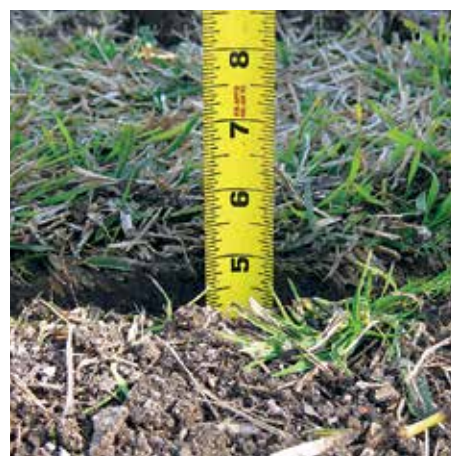
Verificare che la profondità sia costante per tutta l'installazione
